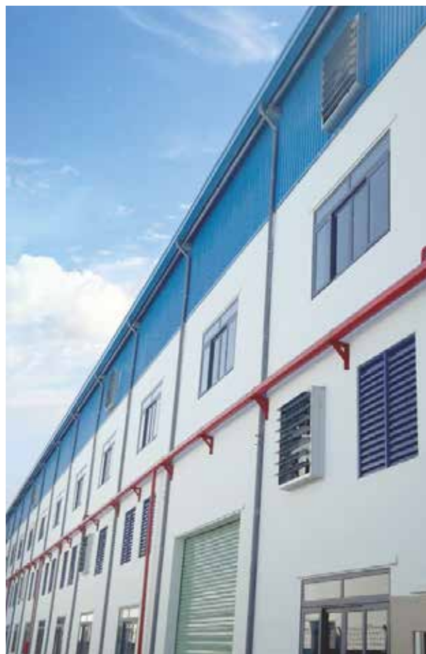
DỰ ÁN: Lắp đặt hệ thống quạt PCCC nhà xưởng tại KCN Nhơn Trạch PROJECT: Installing fire protection fan system at factory in Nhơn Trạch Industrial Park
