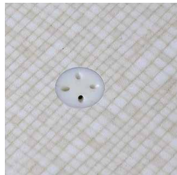
Mặt ván có hệ thống thổi khí Plank surface with air blowing system
